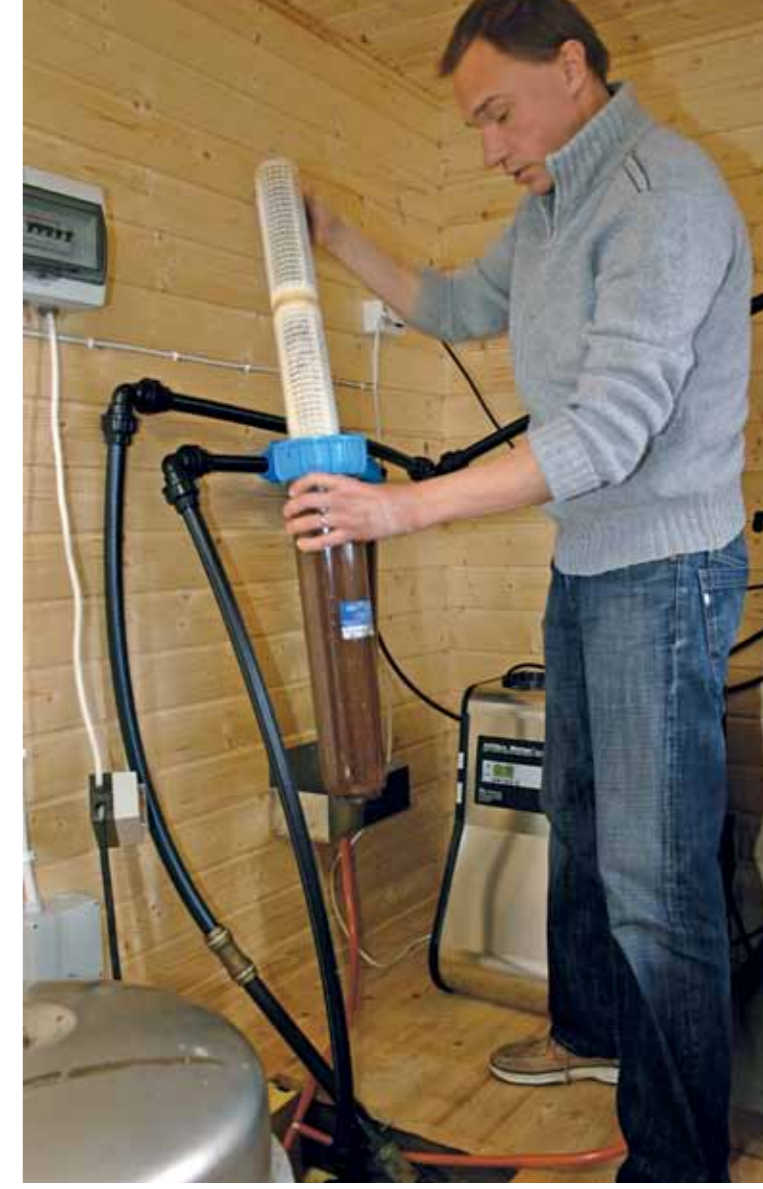
Makeavesilaitte on helppo huoltaa ja huoltotoimenpiteet voi tehdä itse. Käytännössä ainoa säännöllisempi huoltotoimenpide on esisuodattimen puhdistus tai vaihto aika ajoin. Kuvassa oikealla John Oiling näyttää kuinka helposti suodattimen vaihto onnistuu.
